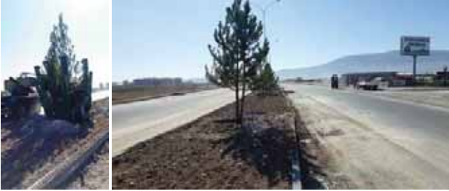
Şekil 223. Ağaç Sökme Dikme Çalışmaları
