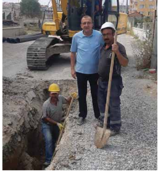
Şekil 270. Dumlupınar Mahallesi Yağmur Suyu Hat Çalışması
