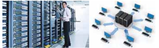
Şekil 37. Sunucu Odası Örneği
