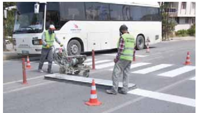
Şekil 67. Yaya Geçidi ve Kasis Boyama Çalışmaları
