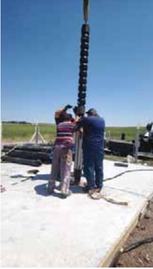
Şekil 268. Parmakören Mahallesi İçme suyu Kuyusu Pompa Çalışması
