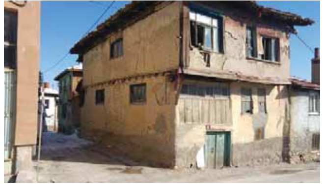
Şekil 152. Hamidiye Mahallesi Doğan Caddesi No: 4-6 (134 pafta 797 ada 19 parsel)
