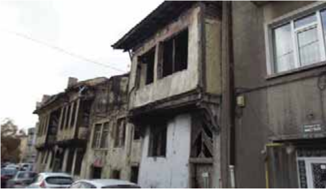
Şekil 155. Saray Mahallesi Mahvel Sokak No: 48-50 (1 pafta 19 ada 4-5-6 parsel)
