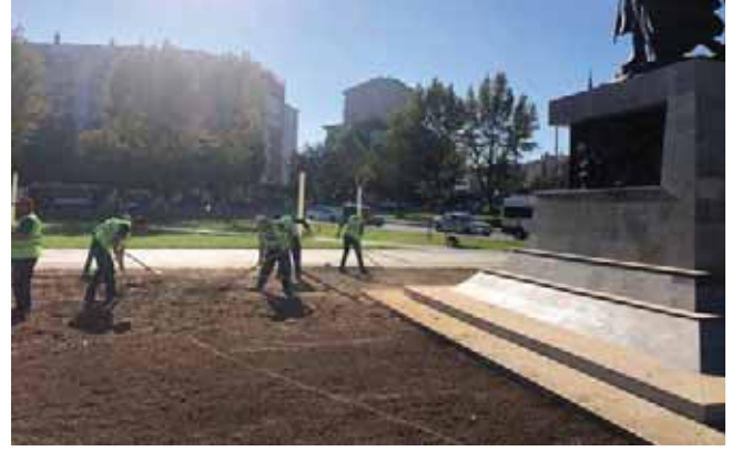
Şekil 221. Belediye önü yeşil alan düzenleme ve sulama sistemi montajı
