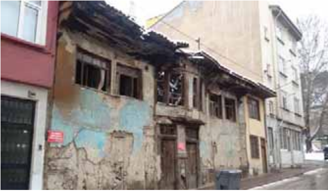
Şekil 146. İstiklal Mahallesi Hamam Caddesi No: 8-10 (63 pafta 387 ada 21-22 parsel)
