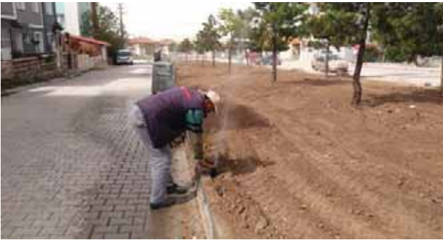
Şekil 220. Yunusemre Mah. Dekor Sok. Refüj Sulama Sistemi Montajı
