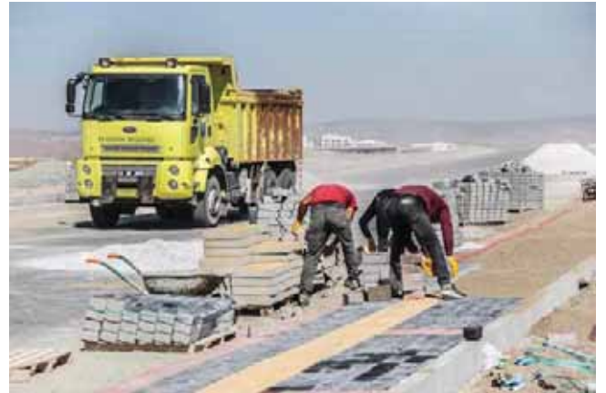
Şekil 70. Kilitli Beton Parke Taşı Yapım ve Tamir Faaliyetleri
