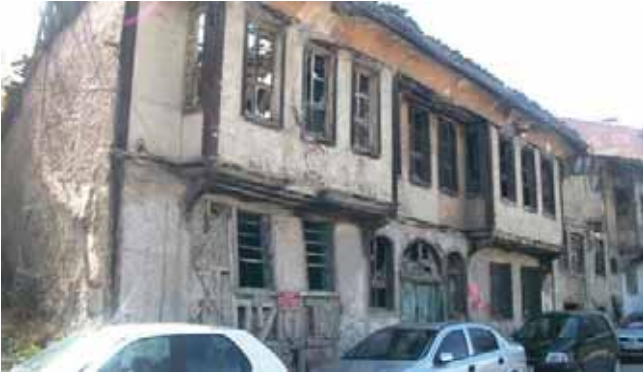
Şekil 156. Saray Mahallesi Mahvel Sokak No: 52 (1 pafta 19 ada 7 parsel)
