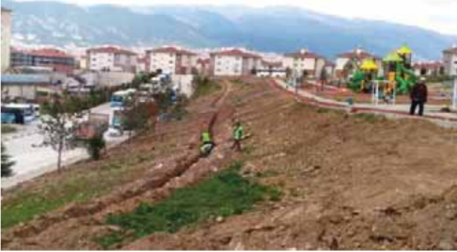
Şekil 219. Akkent Mahallesi Devlet Hatun Parkı Sulama Sistemi Montajı
