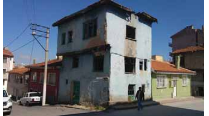
Şekil 144. İstiklal Mahallesi Dülger-2 Sokak No: 2 (623 pafta 391 ada 7 parsel)
