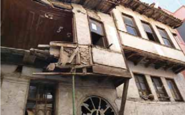
Şekil 162. Mecidiye Mahallesi Telli Sokak No: 5 (10 pafta 33 ada 6 parsel)
