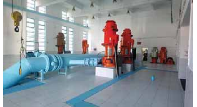
Şekil 267. Porsuk İçme suyu Tesis Binası
