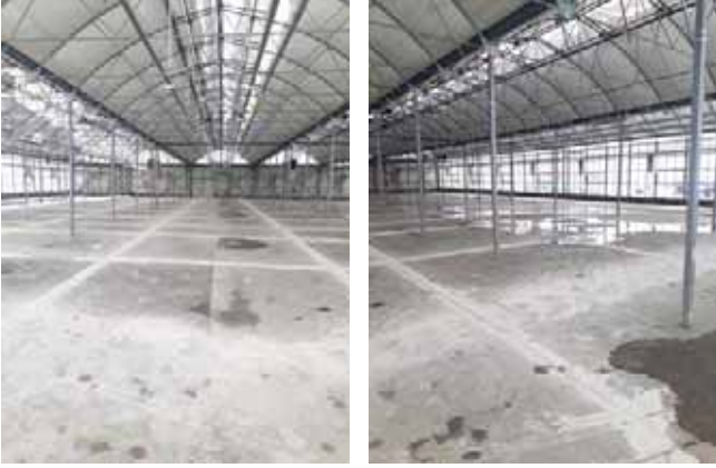
Şekil 77. Şehzadeler Parkı İçi Kapalı Sera Alanı Zemin Betonunu Yapım İşİ
