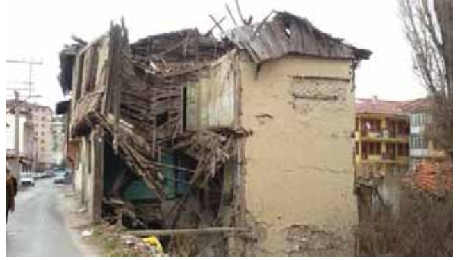
Şekil 149. Cedit Mahallesi Talip Paşa Cad. No: 18-20 (35 pafta 159 ada 49-50 parsel)
