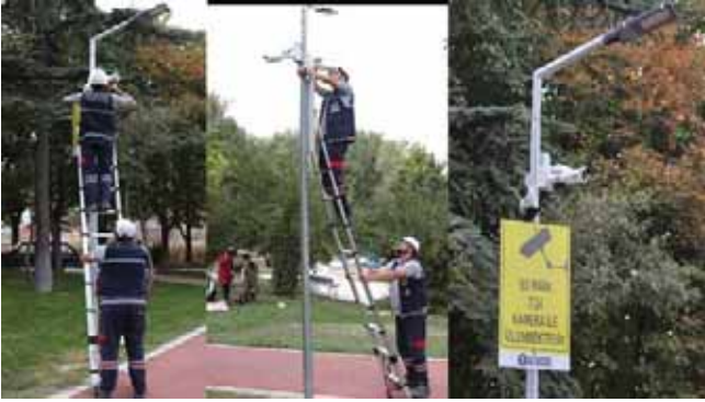
Şekil 214. Ressam Ahmet YAKUPOĞLU Parkı güvenlik kamerası montajı
