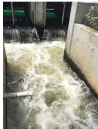
Şekil 263. Arıtma Tesisi Deşarjı
