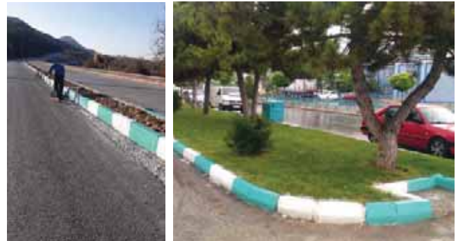
Şekil 217. Bordür Boyama Çalışmaları
