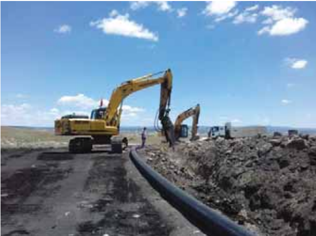
Şekil 258. İçme suyu Servisi Çalışmaları
