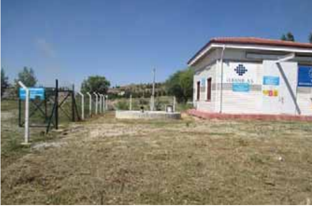
Şekil 265. Yoncalı Atık su Terfi Pompa İstasyonu
