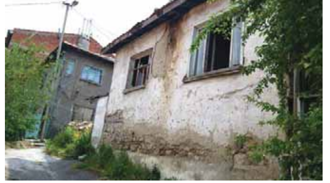
Şekil 141. Börekçiler Mahallesi 1. Hıdırlık Sokak No: 10 (58 pafta 323 ada 6 parsel)
