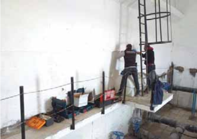
Şekil 259. İçme suyu depolarına otomatik klor dozaj pompası montajı
