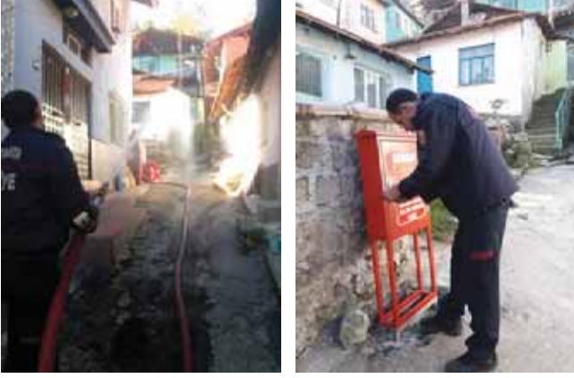
Şekil 181. Yangın Hidrantı Kontrolleri Ve Yeni Hidrant Montajları
