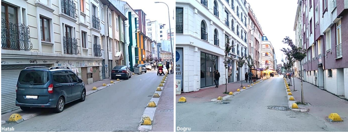
Şekil 9.46. Tek yön ve yol daraltma uygulaması
