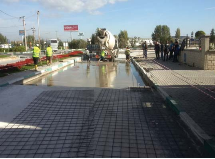
a) Süs Havuzu Yapım İşİ
