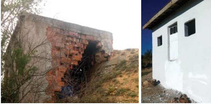
Civli depo eski hali - Civli depo yenilenmiş hali
