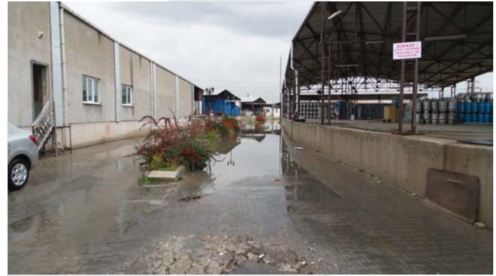
F. Paşa Mahallesi alt kısmına kolektör hat çekilmeden önce sanayi tüpçüler içi yoğun yağmur yağışı sonrası kolektör hat taşkını
