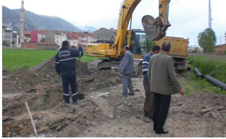
Bahçeli Evler Mahallesi Çeçen Caddesi Yağmur Suyu Hattı Çalışmaları
