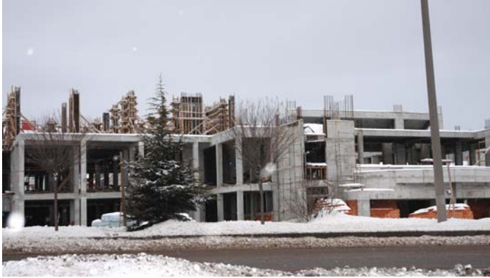
Projenin İnşaat Aşaması
