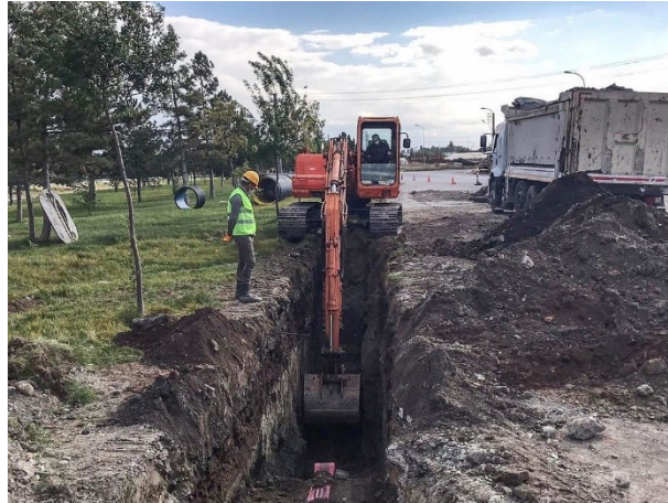
Resim 187. Sanayi Sitesi Yağmursuyu Hat Yapımı
