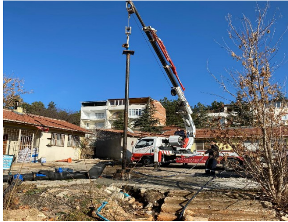
Resim 189. Pompa Servisi Çalışmaları
