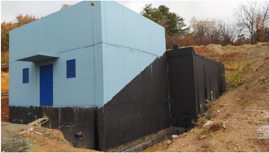
Resim 180. Güveççi Mahallesi içme suyu Deposu
