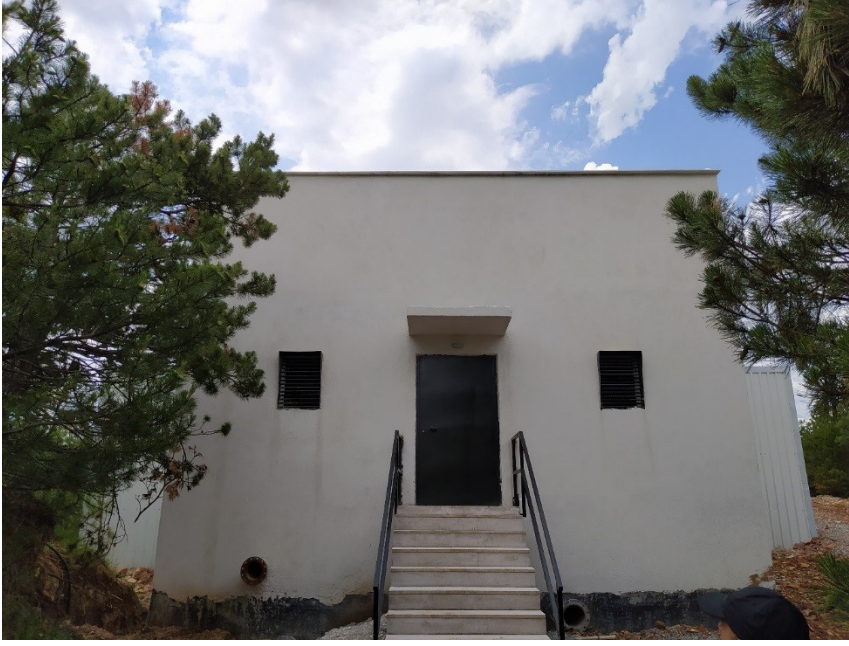
Resim 181. Ilıca Işıkkara Jeotermal Turizm Bölgesine Yapılan Isı Yalıtımlı Sıcak Su Deposu
