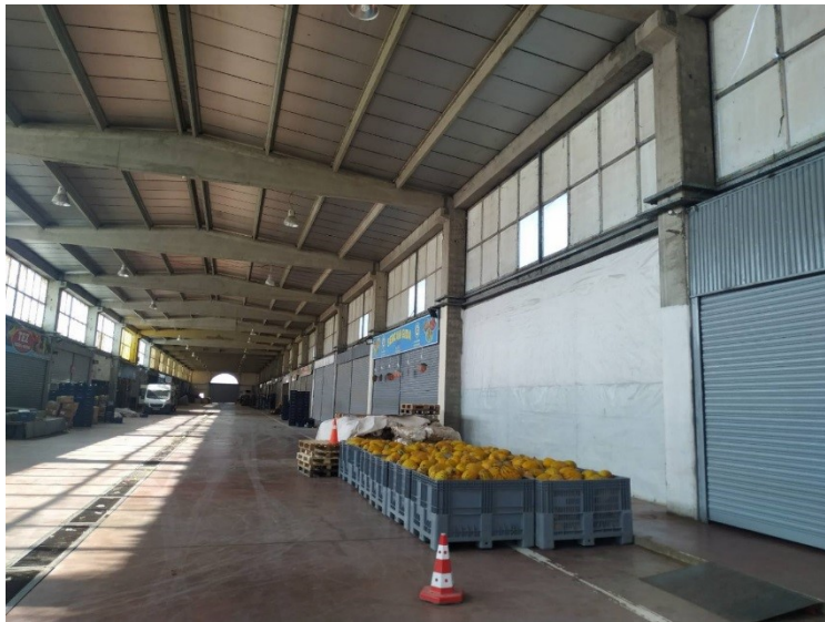
Resim 273. Hal Binası Çatı Tadilatı
