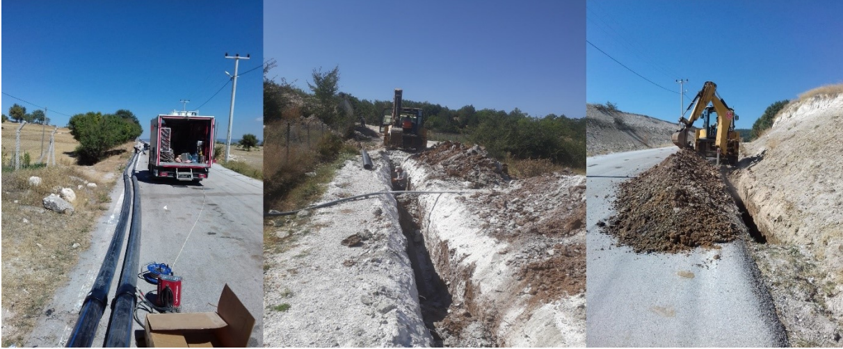
Resim 179. Hacıazizler Mahallesi'nin içme suyu Hat Çalışmaları
