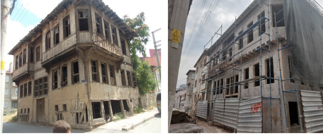
Resim 67. Restorasyon Uygulaması Öncesi-Sonrası
